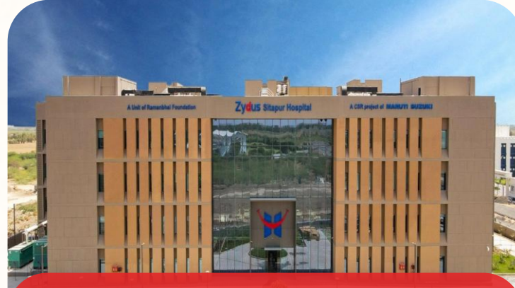
Zydus Hospital Sitapur (Epc Project)
